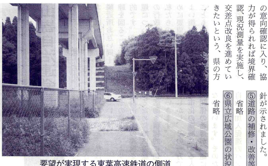
要望が実現する東葉高速鉄道の側道
