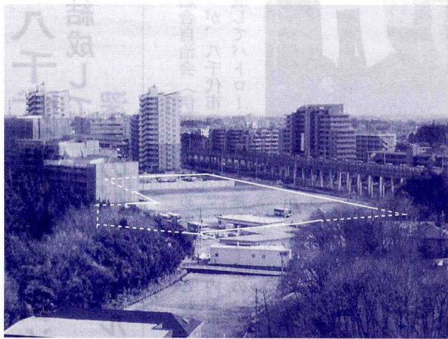
八千代中央駅から徒歩3分の建設予定地(白線部分)
